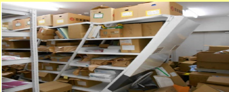
↑熊本県本部 倉庫内 収納棚は斜めによじれるかたちでひし形に変形
