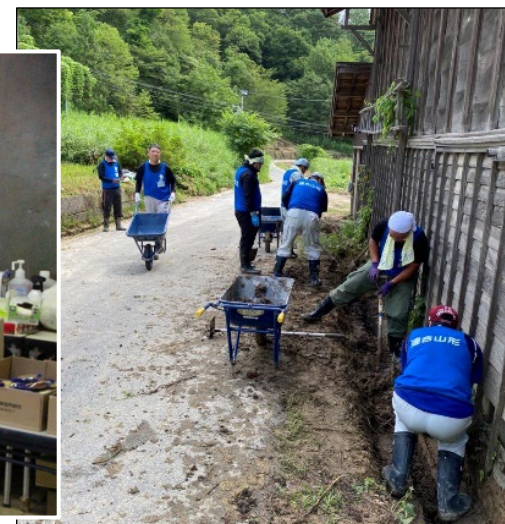
山形県・飯豊町で被災直後に土砂 排除作業する自治労組合員
