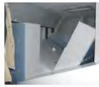
最上階の4階女子更衣室は防災時、避難のため 緊急出口のドアが開かず、避難もコストも取り出せない。
