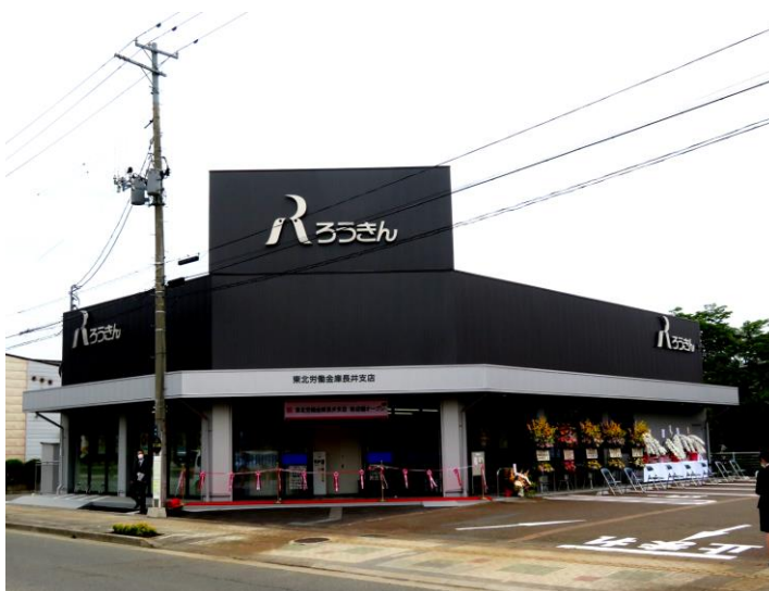
【白つつじ公園側からの新店舗全景】
