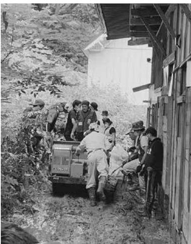
⑤8/12飯豊町。住宅と裏山の間流れ込んだ土砂を撤去。広範囲かつ堆積量の多い現場をマンパワーと運搬機械でなんとか遂行した。
